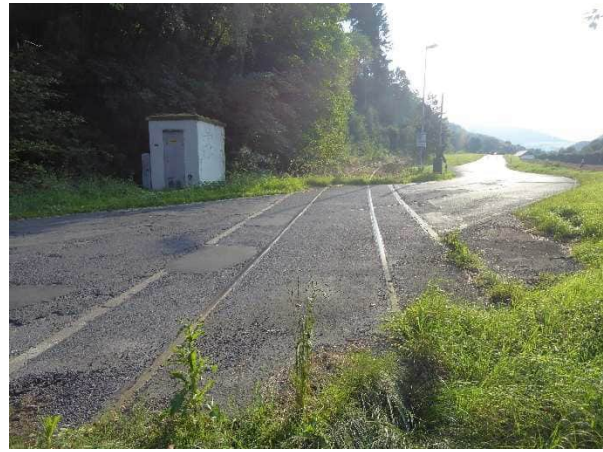
Abbildung 76 BÜ km 1,205 asphaltierter Gleisbereich
