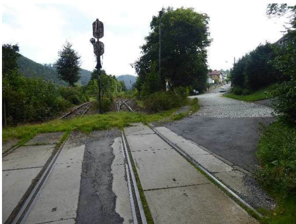
Abbildung 77 BÜ km 5,580 Zufahrt Südseite
