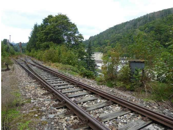
Abbildung 65 Weiche mit Holzunterschwellung Bf Gräfenenthal
