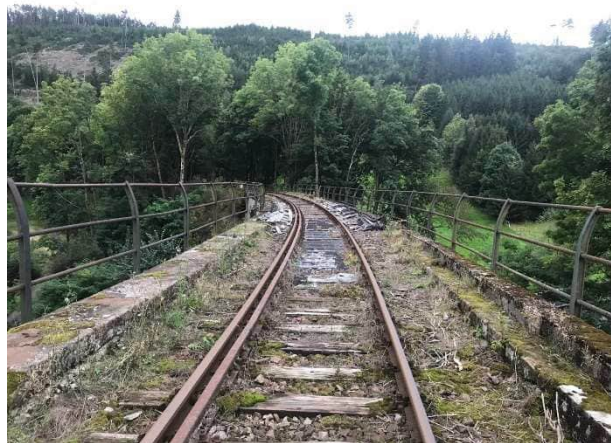
Abbildung 7 Fahrbahn EÜ Lippelsdorfer Viadukt
