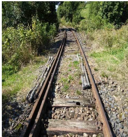
Abbildung 72 Beispiel BÜ mit sonstiger Ausplattung, km 15,860
