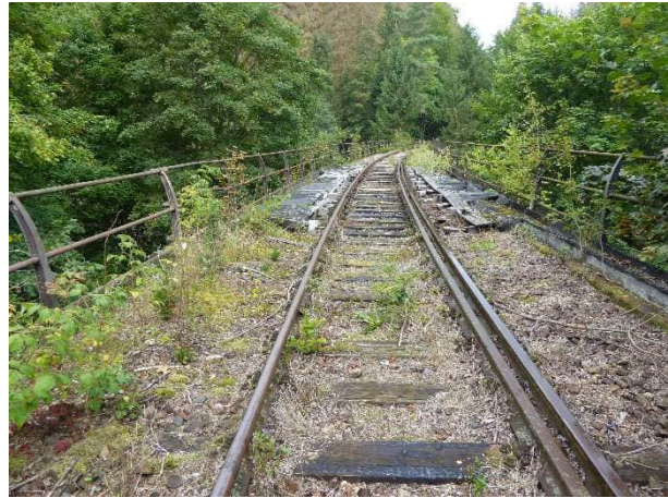
Abbildung 4 Oberbau auf dem Viadukt Sommersdorf
