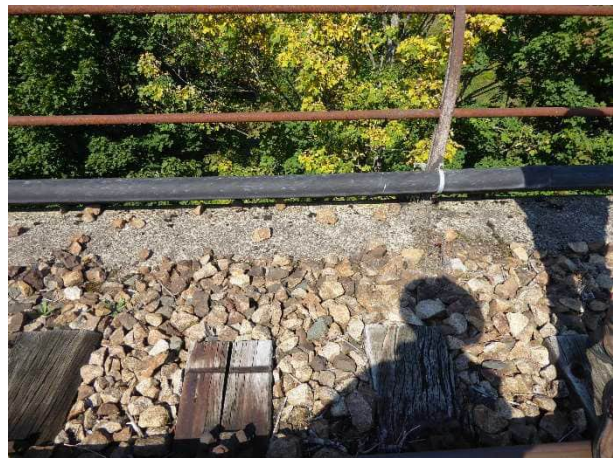
Abbildung 10 loser Schotter auf dem Randweg
