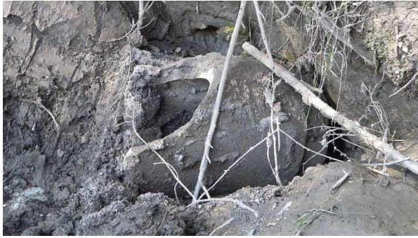
Abbildung 38 DL km 17,800, Einlauf zu kurz, verlängern und profilieren
