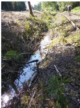
Abbildung 32 stehendes Wasser im Bahngraben km 17,4
