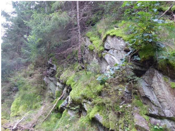
Abbildung 27 Felswand mit offenen Klüften und Rissen km 6,9
