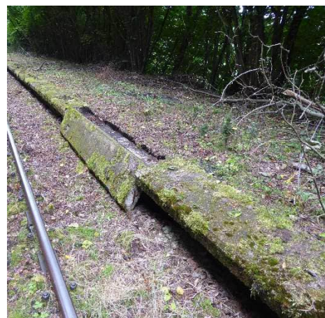
Abbildung 83 abgebrochene Bahnsteigkante
