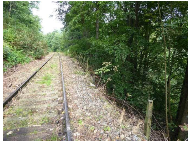
Abbildung 19 Stützmauer km 4,25, zu geringe Höhe
