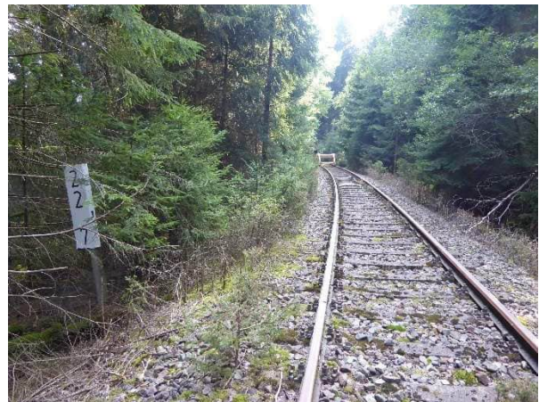
Abbildung 49 Betonschwellen, guter Zustand, Prellbock km 22,75
