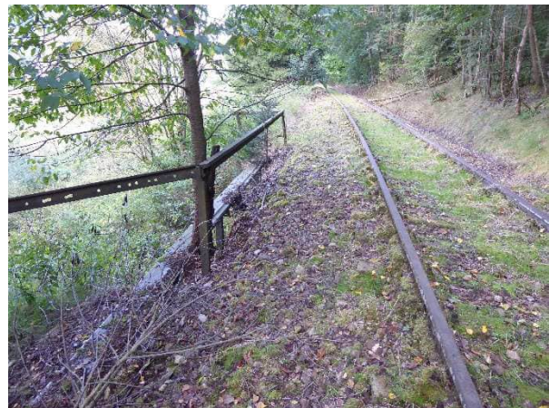
Abbildung 18 Stützmauer km 2,67 br
