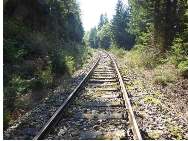
Abbildung 56 Betonschwellenoberbau mit Fahrschiene, km 18,7
