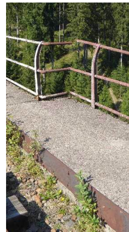
Abbildung 15 geflicktes / gebrochenes Geländer
