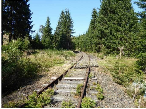
Abbildung 70 Beispiel BÜ mit Holzbohlenausplattung, km 20,910
