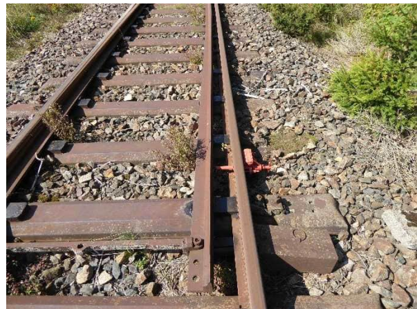
Abbildung 68 verschlossene Weiche Bf Lichte Ost
