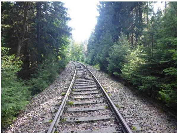
Abbildung 48 Betonschwellen, guter Zustand, km 22,8
