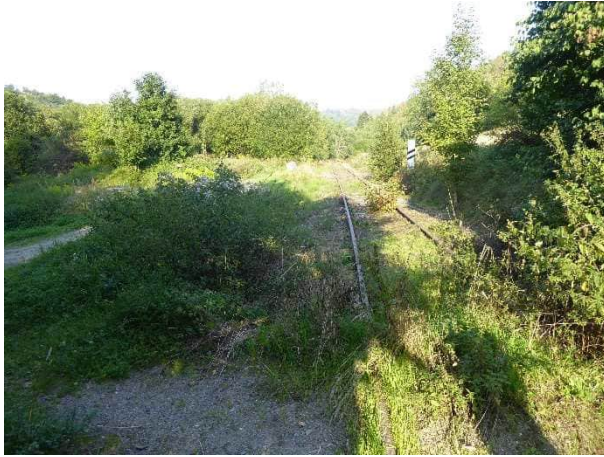
Abbildung 59 Schotterbett verunkrautet und versandet km 1,7
