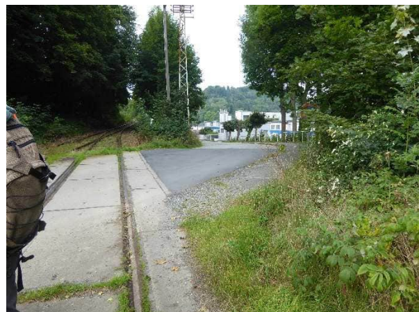
Abbildung 78 BÜ km 5,580 Zufahrt Nordseite
