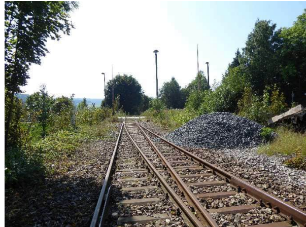
Abbildung 66 Weiche mit Stahlunterschwellung Bf Schmiedefeld
