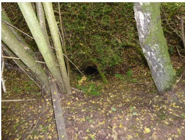
Abbildung 36 DL km 7,500, Einlauf, zu kurz, versandet
