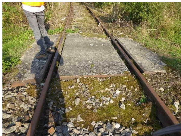
Abbildung 69 Beispiel BÜ mit Betonplatten, km 2,262
