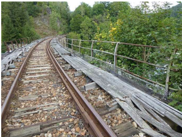
Abbildung 3 EÜ km 6,250 Viadukt Gräfenenthal
