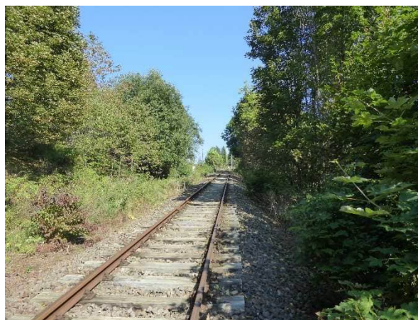
Abbildung 45 Holschwellen, guter Zustand, km 14,7
