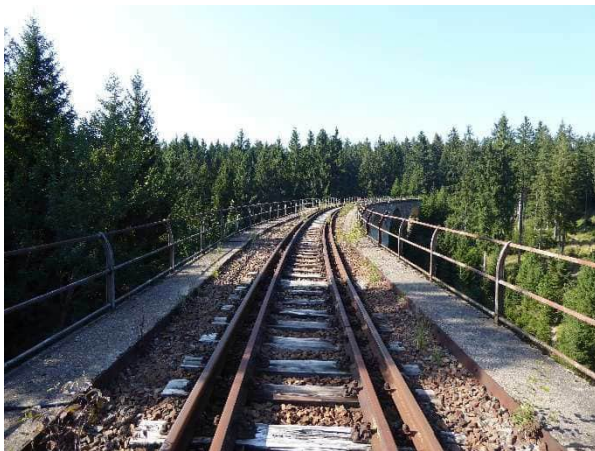
Abbildung 54 Holzschwellen, meist guter Zustand, Viadukt Finsterer Grund
