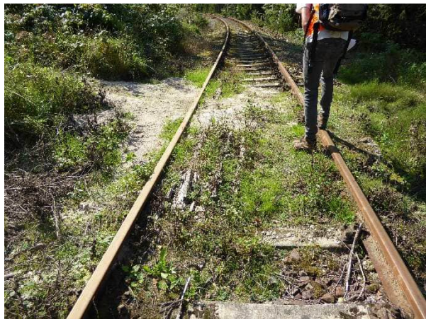
Abbildung 71 Beispiel BÜ mit Sandauffüllung, km 17,420
