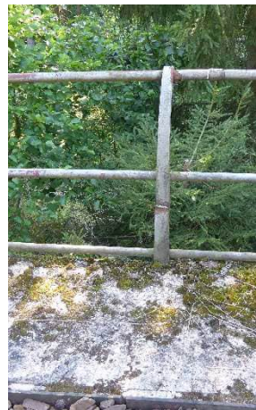
Abbildung 15 geflicktes / gebrochenes Geländer
