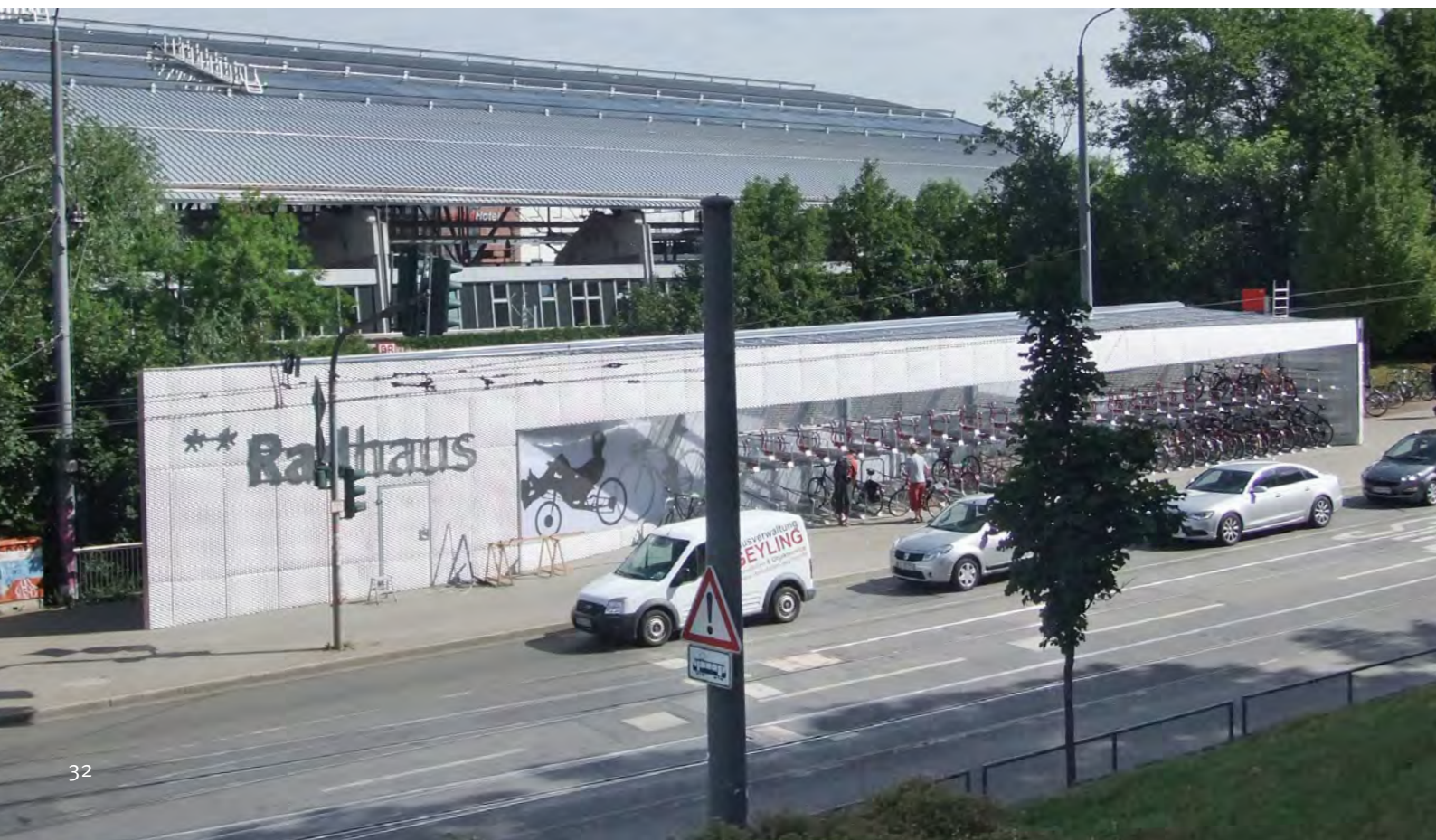
Bike+Ride-Anlage „Radhaus II“ in Erfurt am Hauptbahnhof
