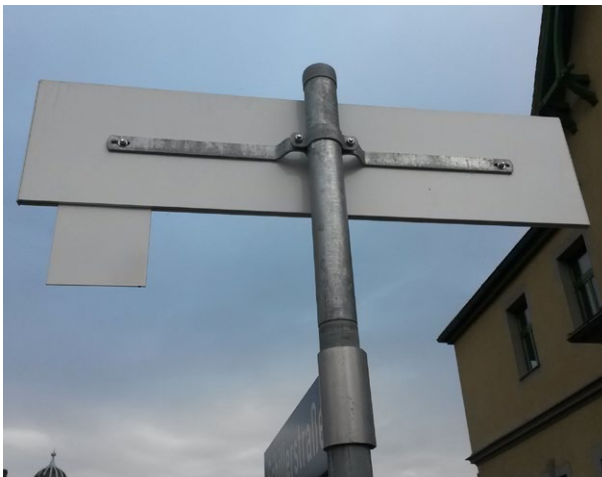
Abbildung 5.14 Tabellenwegweiser mit Rohrschellen an Standardmast befestigt
