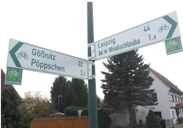
Abbildung 5.13 Pfeilwegweiser mit Stahlbandschellen befestigt
