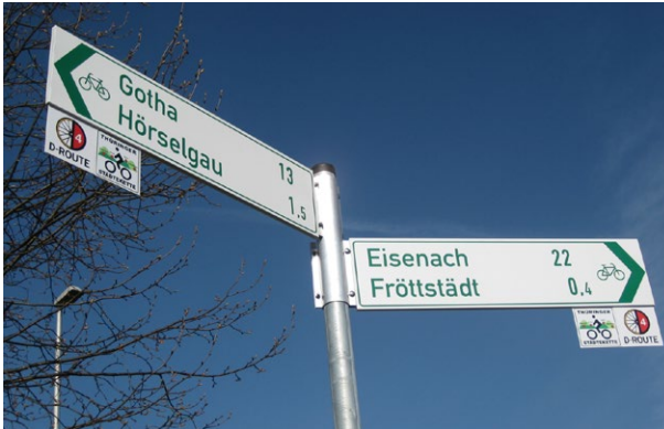
Abbildung 5.12 Pfeilwegweiser mit Aluklemmschellen befestigt
