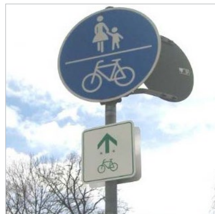
Abbildung 5.10 Zwischenwegweiser mit Verkehrszeichen kombiniert an Standardpfosten mit 60 mm Durchmesser
