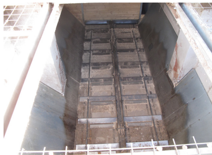
HHS Lagerraum als Tiefbunker im Haus 8
